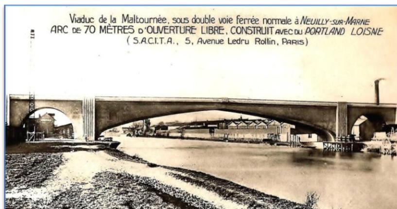
Traversée de la Marne à Neuilly, début des travaux de construction du viaduc ferroviaire en béton armé, celui-ci sera achevé en 1928. Il sera détruit pendant la guerre de 39-45, et sera reconstruit à l'identique.
